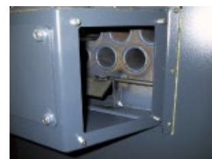
Røggasse med afmonteret renselø
