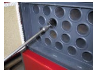
Rensning af rørør
