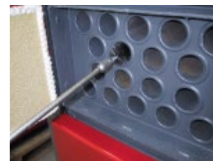
Rensning af rørør
