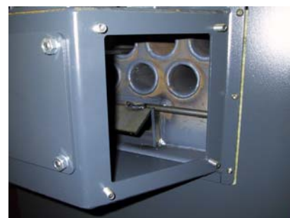
Rensning af røgkasse (vist med afmonteret sideplade)
