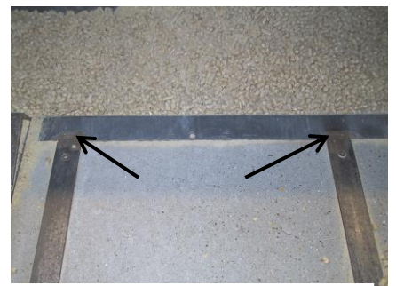
Fladjern svejset fast til kanten på skrabekanalen
